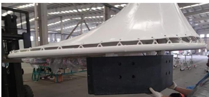
Emboîtez le toit 3 au-dessus de la structure 1.2.
